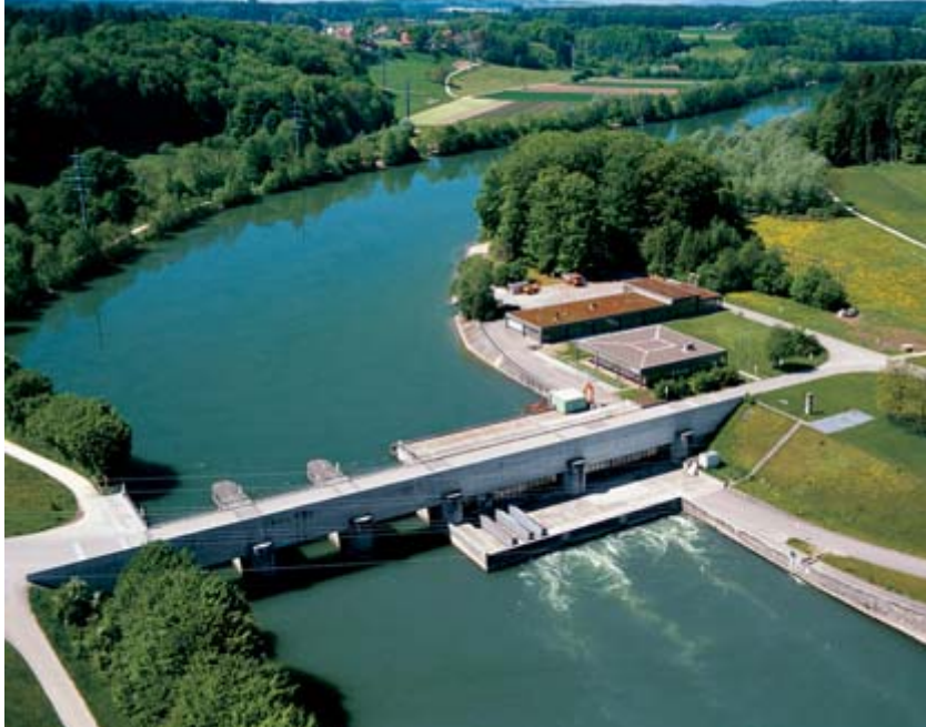
Centrale hydroélectrique de Bannwil
