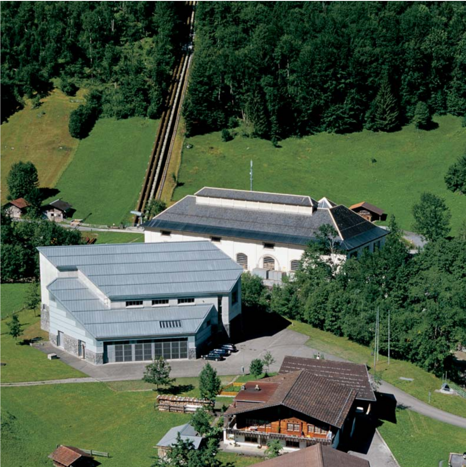
La centrale de Kandergrund: conduite forcée et ancienne salle des machines
